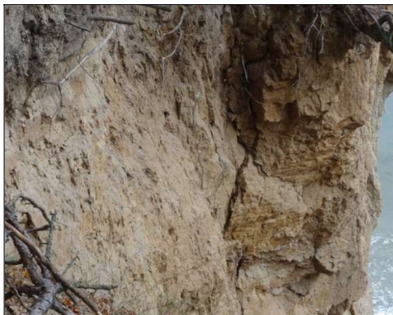
Fot. 19. Pęknięcia widoczne w górnej części Cypla Redłowskiego, materiał niedługo może ulec odpadaniu. Zdjęcie własne.
